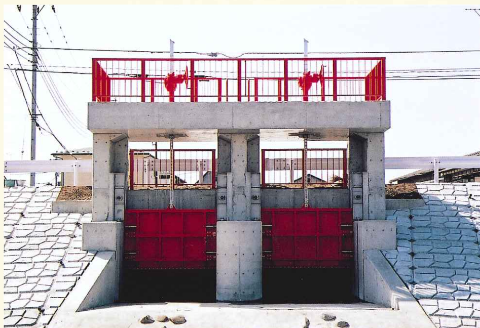
鋼製ローラーゲート（ラック式）4方水密式 W2350×H1500×2門 鹿沼市貝島町
