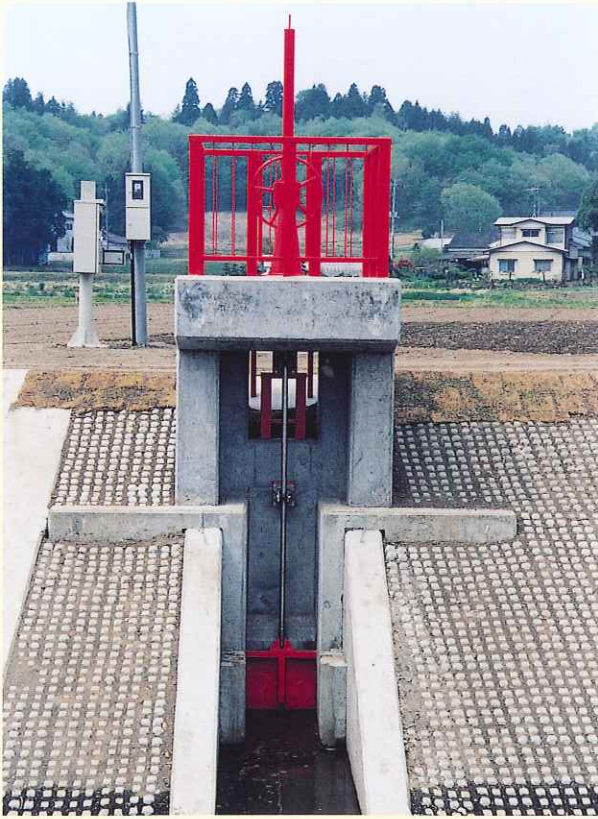
鋼製スライドゲート（べベル式）4方水密式 市貝町（小貝川）W600×H600
