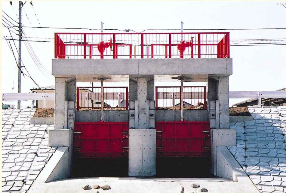
鋼製ローラーゲート（ラック式）4方水密式
